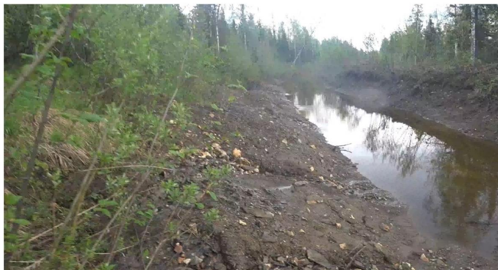
Рисунок 7.16. Руслоотвод на участке проведения работ (впадение ручья Еськин)
