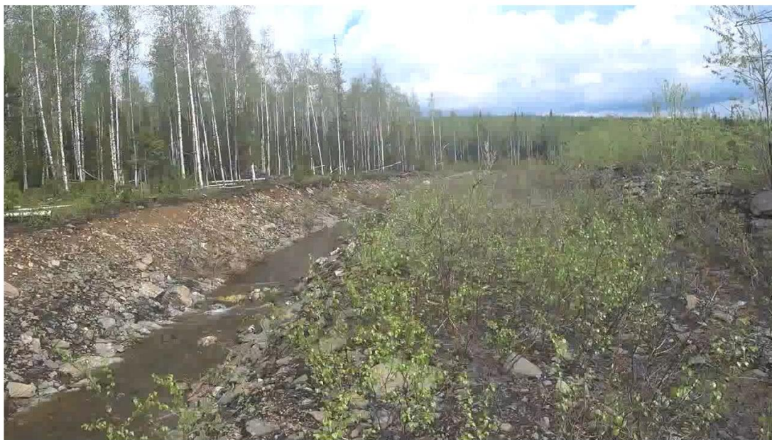
Рисунок 7.1. Руслоотвод на участке проведения работ (начальный участок)
