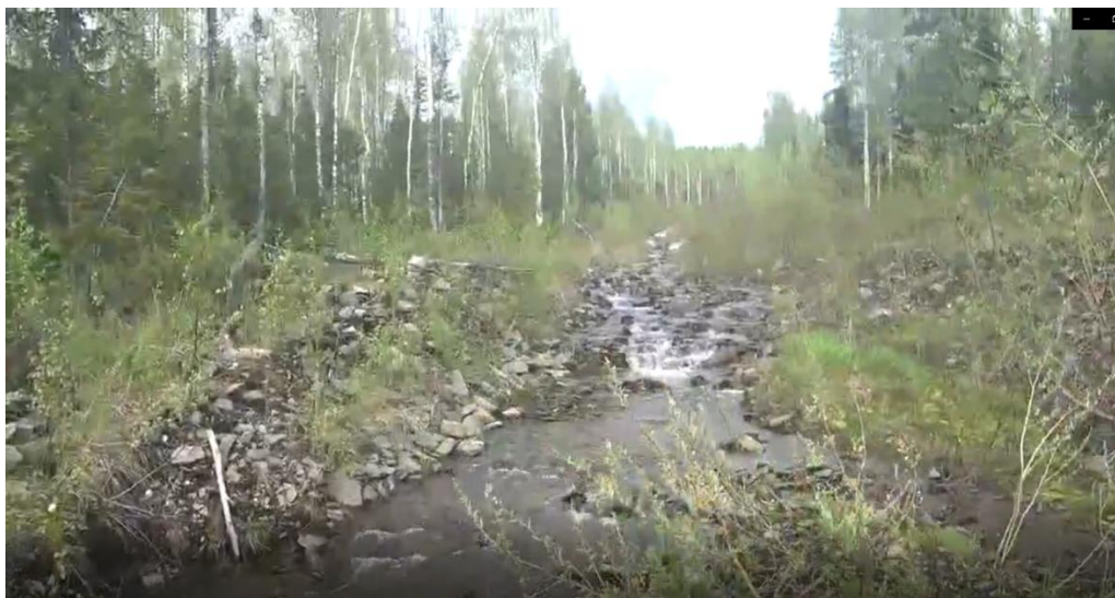
Рисунок 7.3. Руслоотвод на участке проведения работ (начальный участок)
