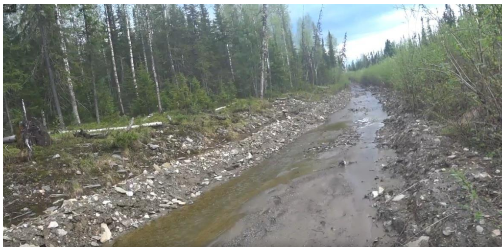
Рисунок 7.15. Руслоотвод на участке между впадением ручья Оськин и ручья Еськин
