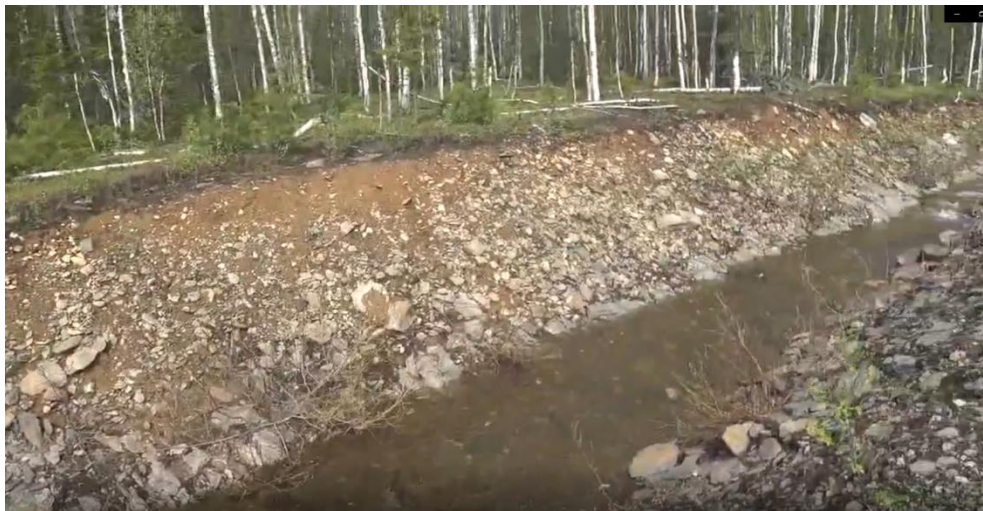
Рисунок 7.2. Склоны руслоотвод на участке проведения работ
