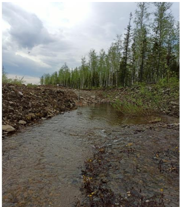
Рисунок 7.19-7.20. Руслоотвод на участке проведения работ
