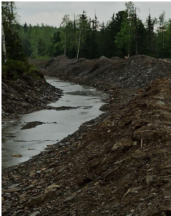
Рисунок 7.19-7.20. Руслоотвод на участке проведения работ
