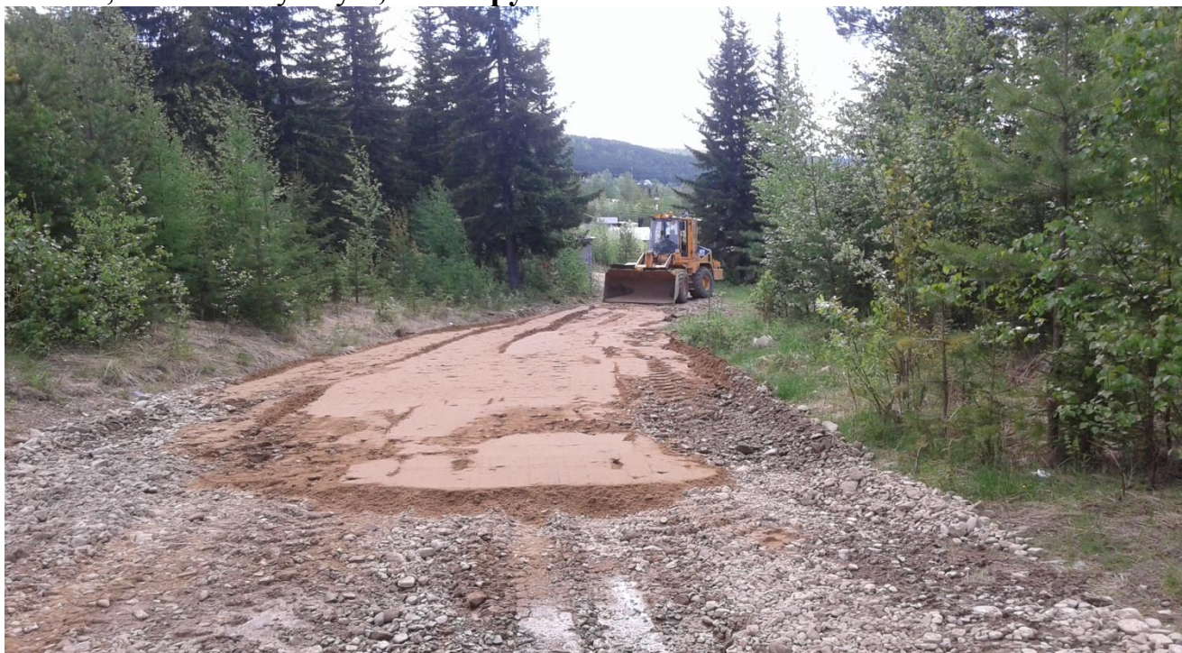
Отсыпка дороги ул. Нагорная, п. Новая Калами
