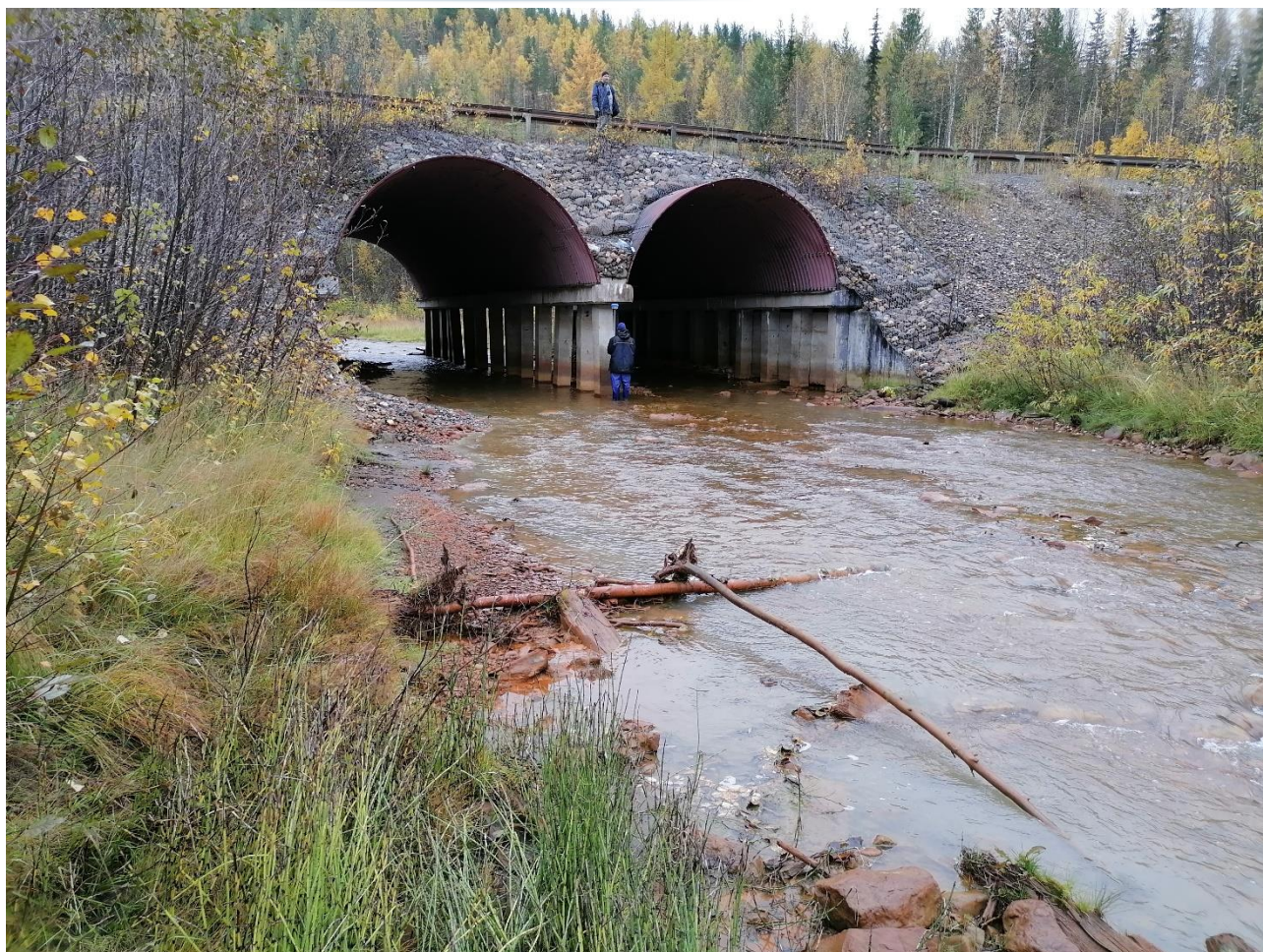
Рисунок 8 – Следы карчехода (стволы деревьев в русле р.Огнё)
