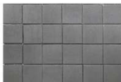
Тротуарная плитка на цементно-песчаном основании (недренирующая)
